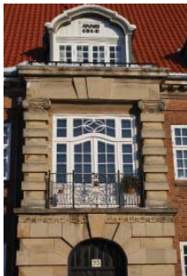
Kasernebyens gamle bygninger rummer mange spændende bygningsmæssige detaljer - som her hovedindgangen til kommandørboligen.
